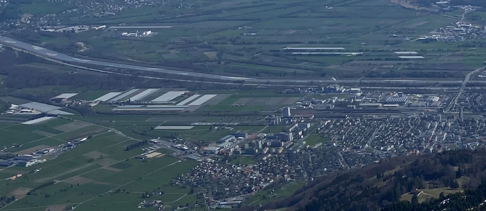
Die Stadt Buchs im Alpenrheintal (Blick vom Buchserberg in Richtung Osten) ▲
