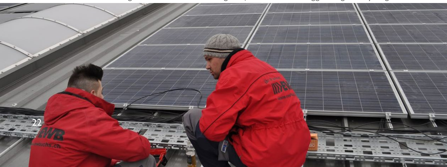
Montage einer Photovoltaik-Anlage auf dem Dach der Eggenberger Recycling AG in Buchs ▼
